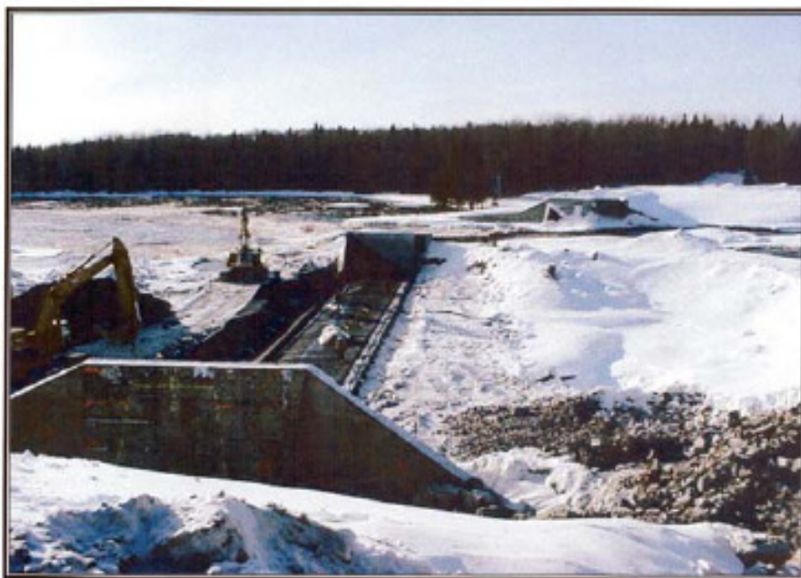
Vue d'ensemble du barrage est. Pose du ballon dans la section de 60m. Le 20-02-2000.
