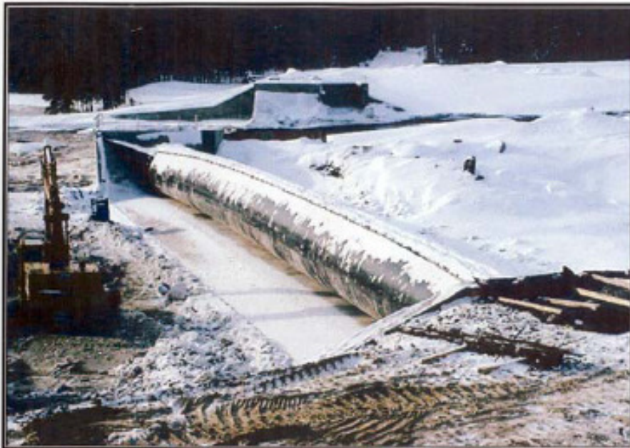
Ballon gonflable, section de 60 mètres au barrage est. - Le 27 Janvier 2000.
